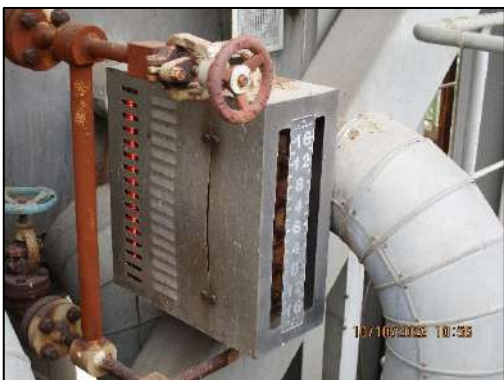
รูปที่ 2-66 เครื่องวัดระดับน้ำ ของหม้อไอน้ำ
