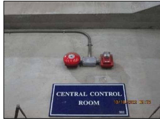
รูปที่ 2-44 ระบบสัญญาณเตือนอัคคีภัย (Fire Alarm)
