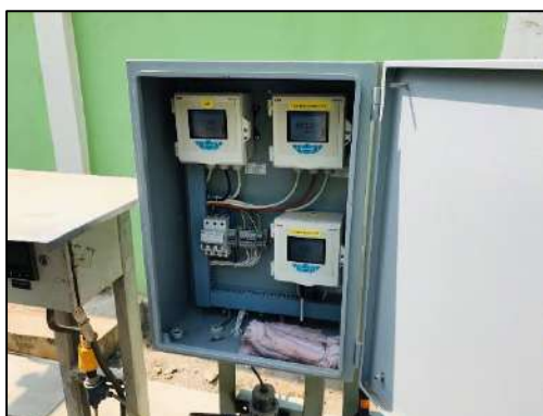
รูปที่ 2-25 เครื่องตรวจวิเคราะห์คุณภาพน้ำอัตโนมัติ
