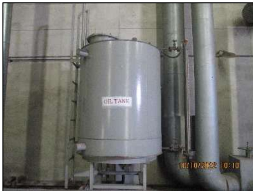
รูปที่ 2-68 Emergency Gravity Oil Tank
