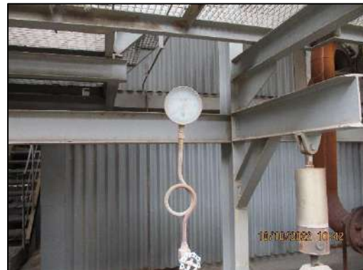
รูปที่ 2-59 Pressure Gauge ของหม้อไอน้ำ
