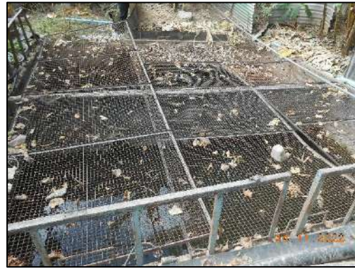
รูปที่ 2-27 ตะแกรงดักขยะมูลฝอย ก่อนระบายน้ำลงสู่ระบบบำบัดน้ำเสีย
