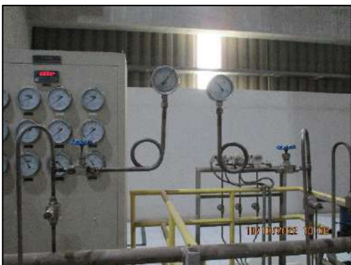
รูปที่ 2-64 Pressure Transmitter ของหม้อไอน้ำ
