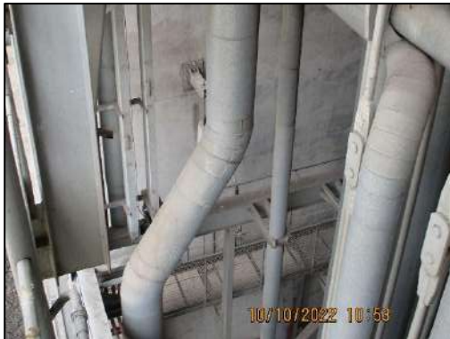
รูปที่ 2-62 Rapid Drain Piping System ของหม้อไอน้ำ
