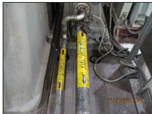
รูปที่ 2-67 ระบบท่อน้ำมันเลี้ยงเบรจ ของ Turbine&Generator
