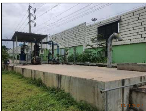
รูปที่ 2-24 บ่อปรับสภาพขนาด 1,000 ลบ.ม. (บ่อตั้งอยู่ใต้ดินมีปั๊มตั้งอยู่เหนือบ่อ)
