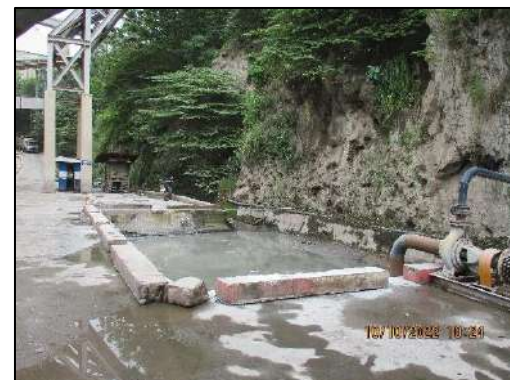
รูปที่ 2-61 บ่อพักน้ำ Blow Down ใต้ CFBC Boiler
