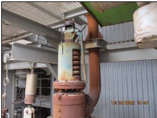
รูปที่ 2-58 Safety Valve ของหม้อไอน้ำ
