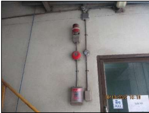
รูปที่ 2-44 ระบบสัญญาณเตือนอัคคีภัย (Fire Alarm)
