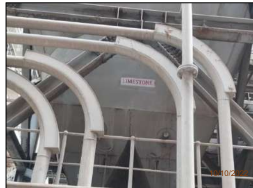
รูปที่ 2-10 ระบบ Limestone Injection
