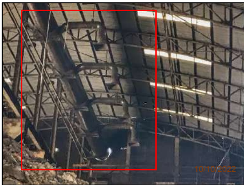
รูปที่ 2-74 พัดลมดูดอากาศในโรงผลิต RDF
