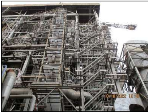
รูปที่ 2-56 CFBC Boiler ที่มีทางเดินและบันได พร้อมราวกันตก
