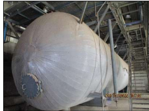
รูปที่ 2-57 Steam Drum ของหม้อไอน้ำ
