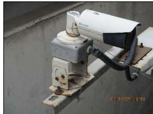
รูปที่ 2-63 การติดตั้งกล้องวงจรปิด สำหรับตรวจสอบระดับน้ำ ของหม้อไอน้ำ
