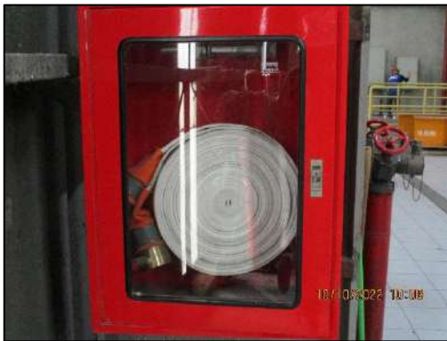
รูปที่ 2-45 ท่อดับเพลิงและตู้เก็บสายดับเพลิง
